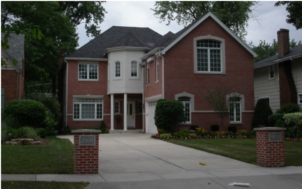
188 N. Poplar – Elmhurst, IL New Construction
