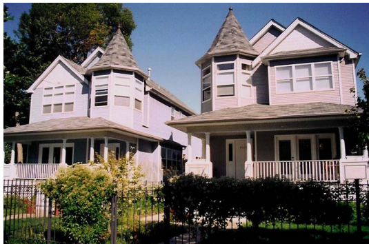
4523-4525 N. Hamilton – Chicago, IL New Construction
