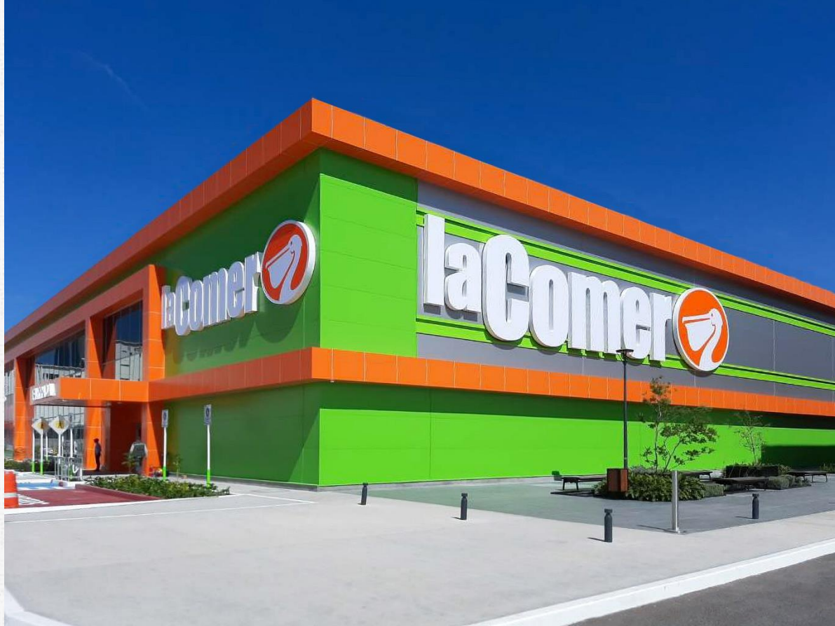
La Comer – La Comer Aguascalientes Altaria
