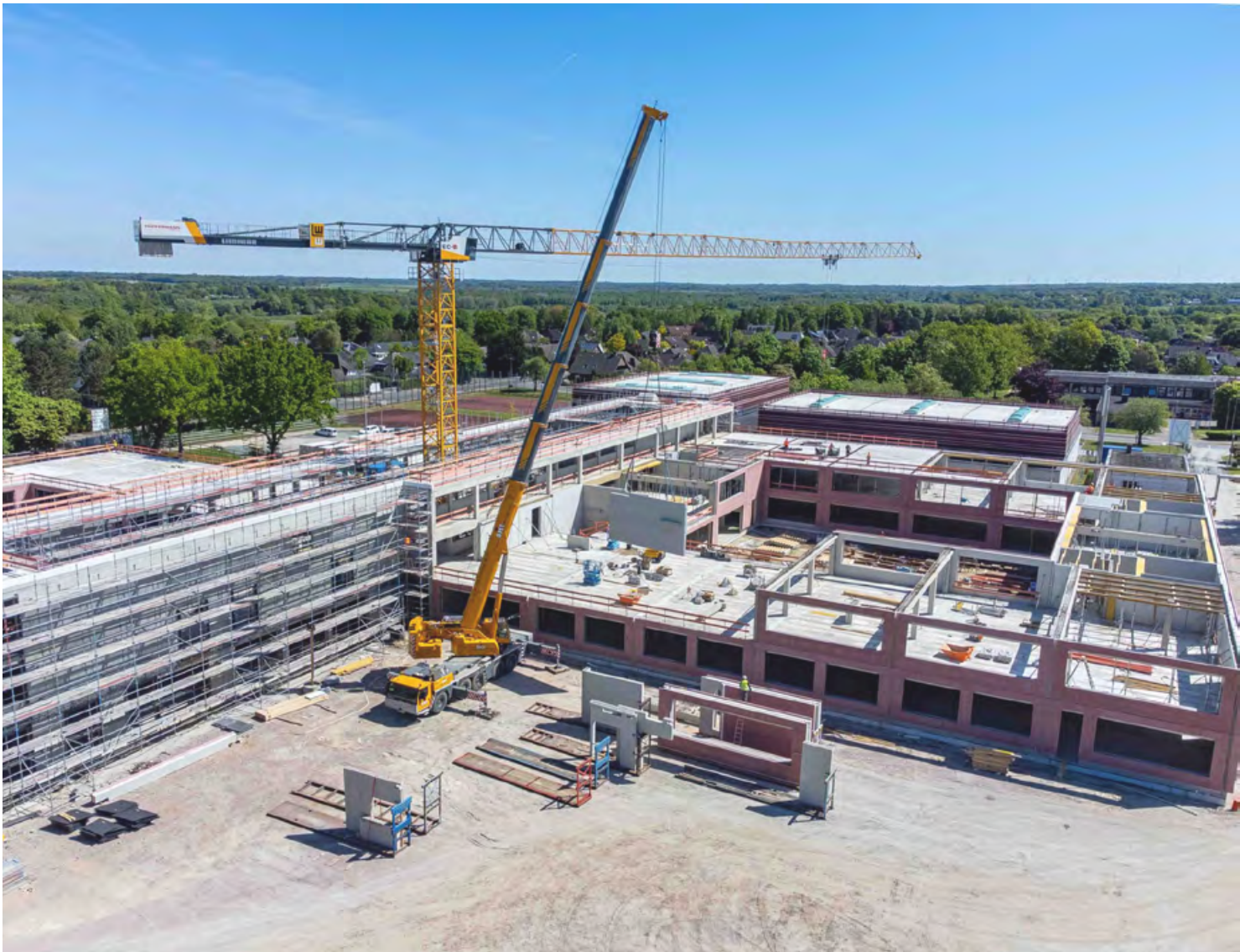
Site Photos - Credits: ppp Architekten
